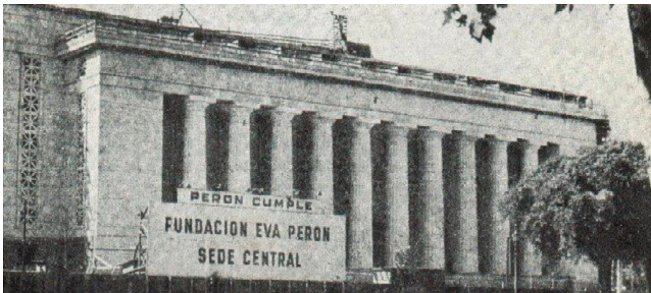
Sede central de la Fundación Eva Perón en la Ciudad de Buenos Aires sobre la Avenida Paseo Colón, actual Facultad de Ingeniería de la Universidad de Buenos Aires.
